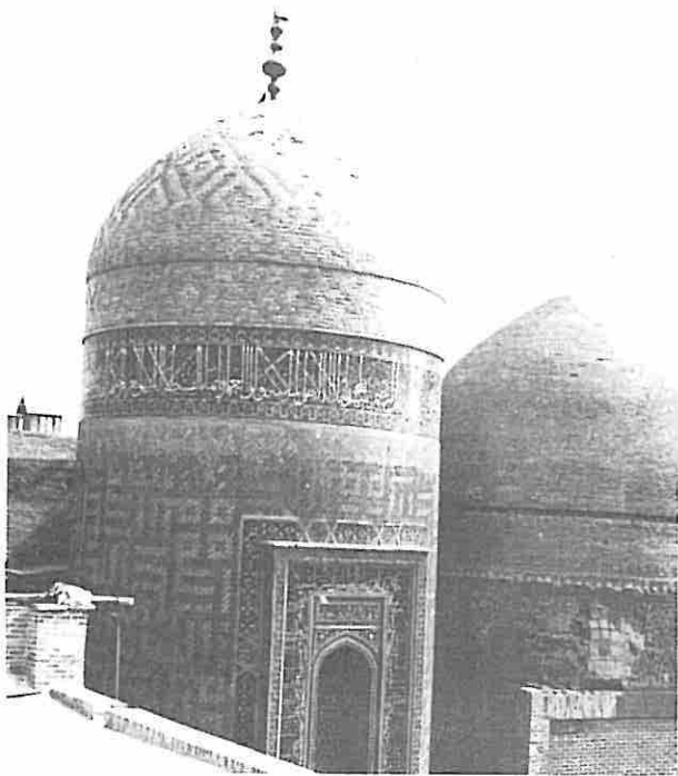
اردبیل - بقعه شیخ صفی خود گنبد بصورت پاتویا اجرا شده A
