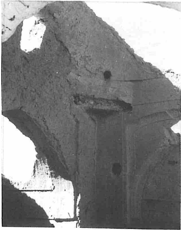
یزد - منطقه شهدای فهرج - لب بند ترنبه با چوب است که موریانه آنرا خورده و اکنون تنها آثار آن دیده میشود A
