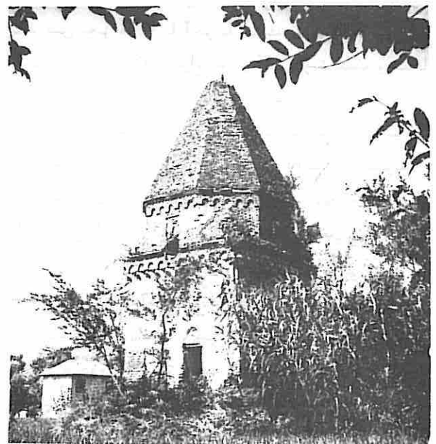
بابل - برج سرست درویش عزیز چیدن گنبد بصورت رگچین A
