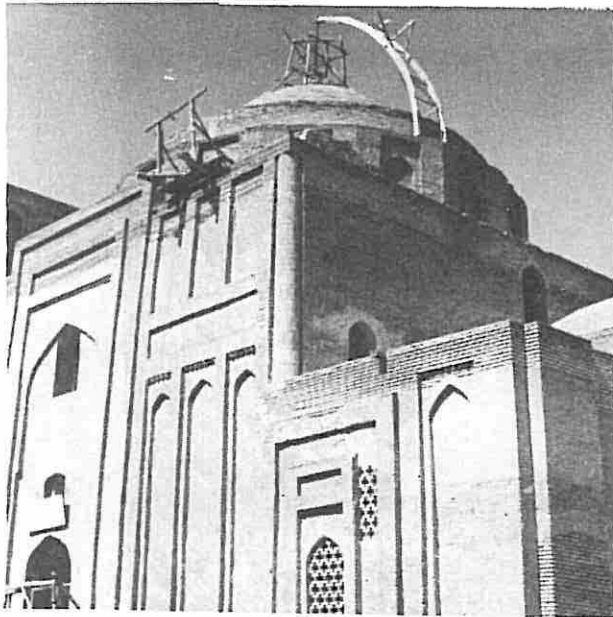
مشهد- طوس بنای هارونیه اجرای (خود) گنبد به شیوه متداول منطقه
