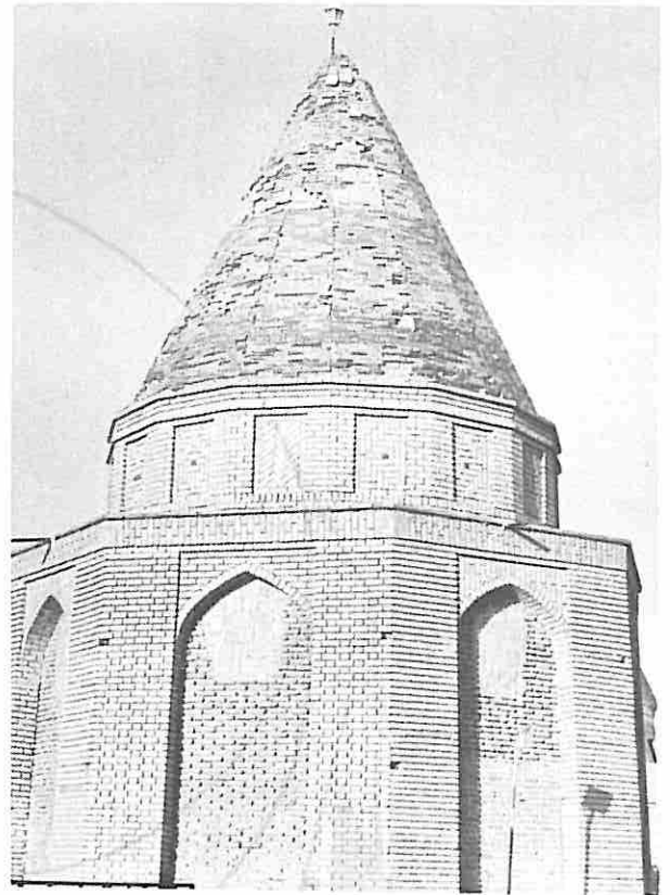
قم - یکی از مقابر دروازه کاشان - گنبد رک ۱۲ ضلعی است A
