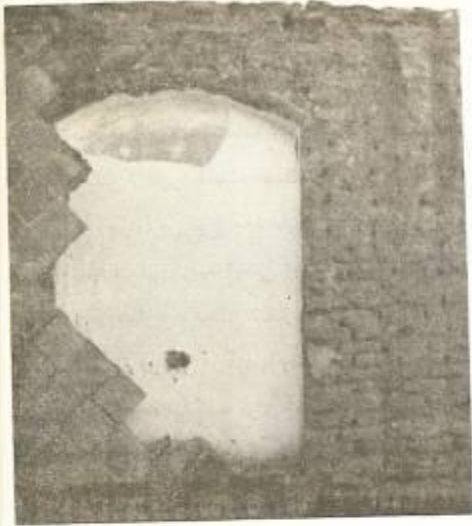
عکس شماره ۳۸ - خانه‌ای در سبزوار پوشش درگاه بصورت چپله است (عکس از علی الدانغی)
