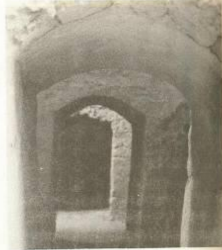
عکس شماره ۱- تپه نوشیجان- ملایر طاق ضربی مربوط به دوران مادها (عکس از بیژن رفیعی)
