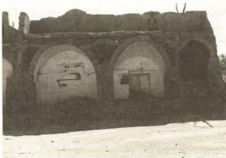
عکس شماره ۳۱- یکی از روستاهای فضل آباد بین راه بم به زاهدان - ترماشور یک نوع کنومازی که در اینجا کنو در همان جهت طاق اصلی زده شده است (عکس از مهندس مهرباد)
