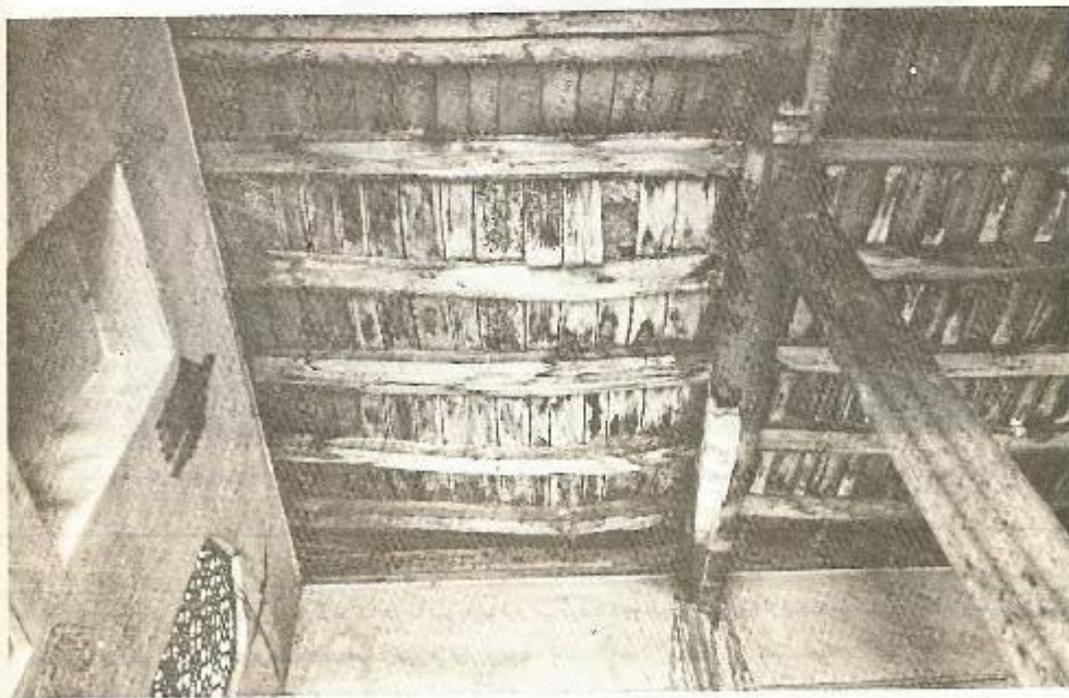
عکس شماره ۹۱ - مسجد صفوی ایبانه - ساده‌ترین تیروپوش متشکل از تیروهای جمال شاه تیر - تیروچه نخته
