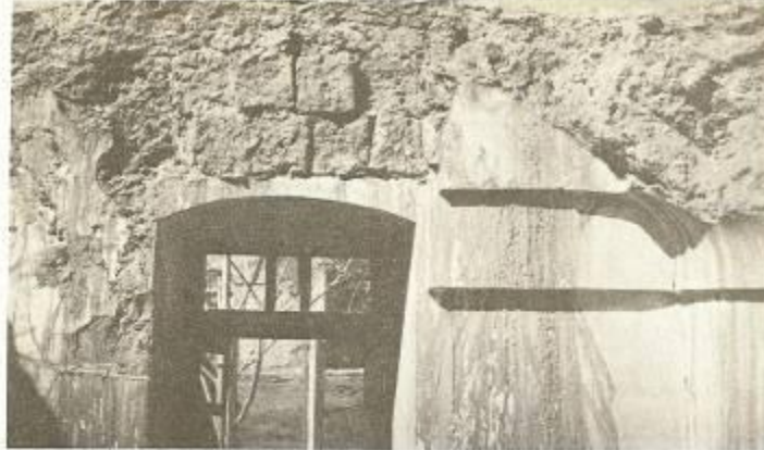
عکس شماره ۱۳ - خانه‌ای در سیزوار - پوشش درگاه بصورت چپله است (عکس از علی الداغی)
