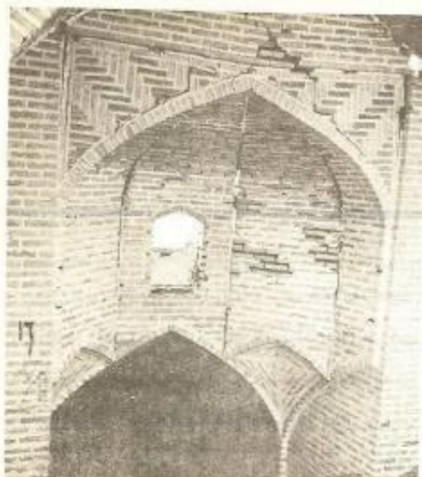
عکس شماره ۴۱- آب آبتاری در یزد استفاده از چند غلط و شکست آن در ناحیه ایوان گاه
