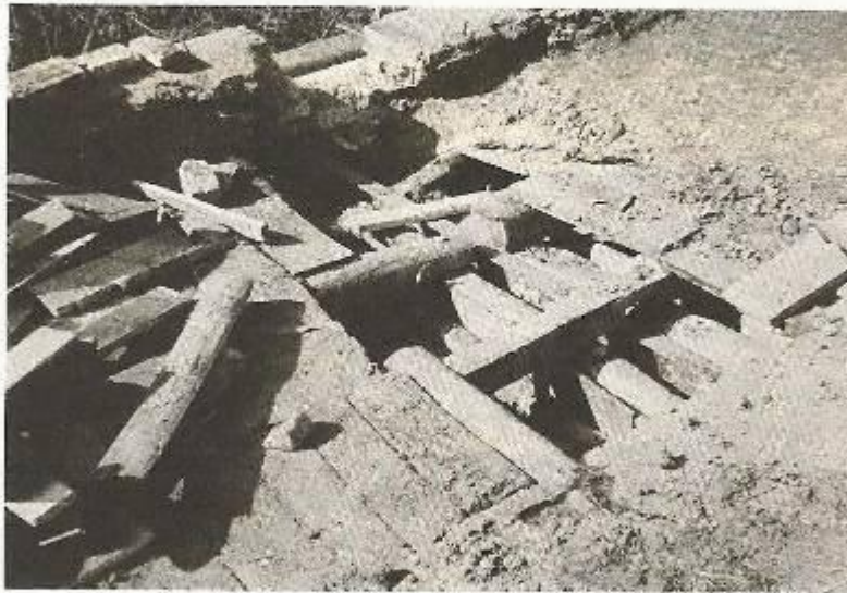
عکس شماره ۸۹- یزد- زرجان- اتصالات سقف چوبی مسجد جامع (عکس از غلامرضا حسین زاده)
