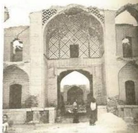
عکس شماره ۴۲- کاروانسرای مرعجاب کاشان شکست چند بخصوصی در ناحیه تیزه
