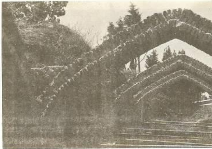
عکس شماره ۱۱- مجموعه فرح آباد سازی- ساختن تویزه (عکس از رضا نصیری)
